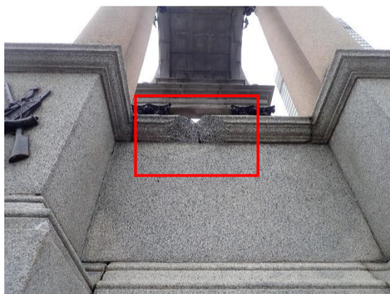
Photo 5 : pierre fissurée, vue du bas
