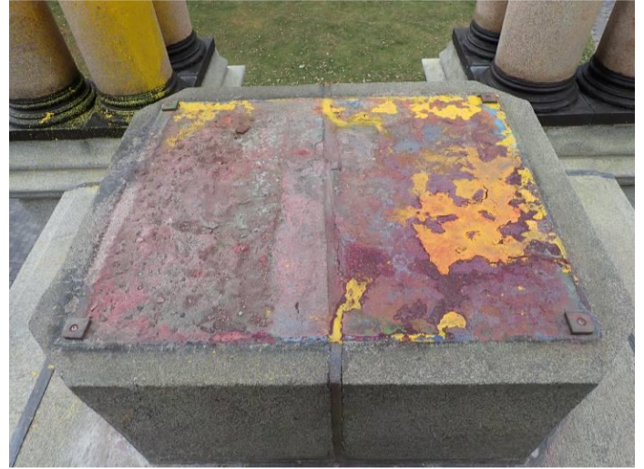
Photo 9 : résidus (nouveaux et anciens) de peinture sur le socle de pierre sur lequel est habituellement déposée la sculpture
