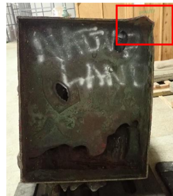
Photo 16 : déformation au niveau de la terrasse
