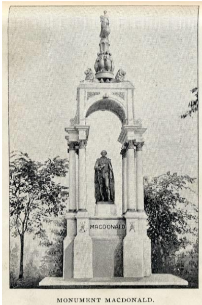
Photo 1 : Photo du monument, 1897, provenant du Guide de Montréal et de ses environs , par A. Leblond (BANQ)
