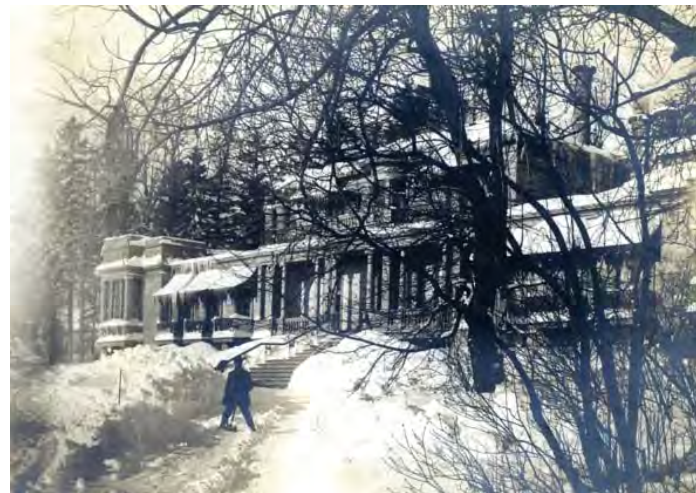
1910 Résidence du capitaine William Raynes, avenue Forden
