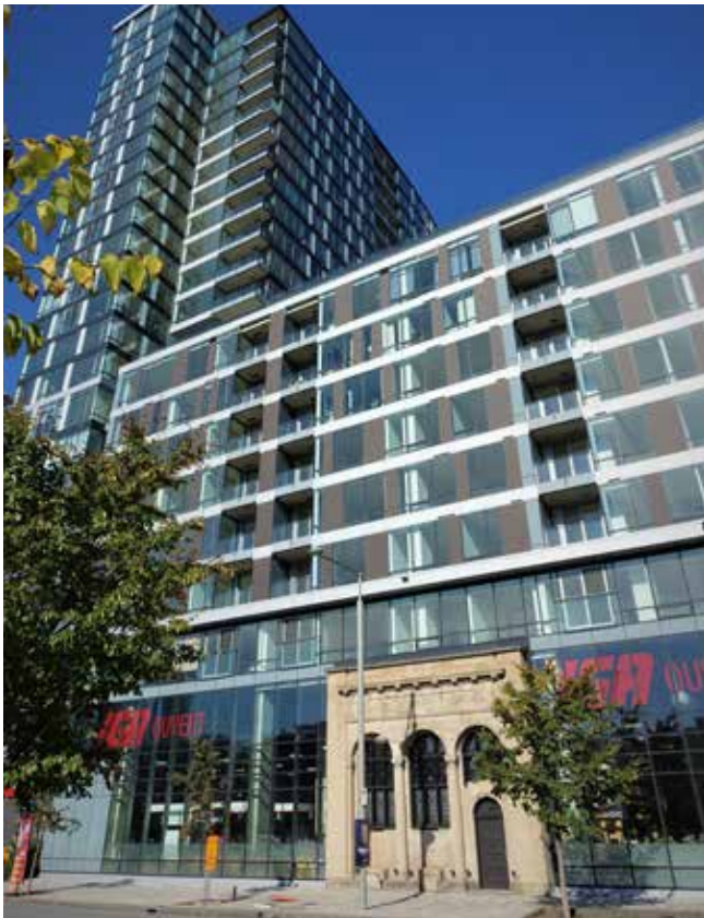
La façade et une partie de la structure de l'ancienne banque Duke Investments Limited, érigée en 1927, ont été intégrées à la devanture d'une tour commerciale et résidentielle construite en 2010 sur le boulevard Robert-Bourassa.
