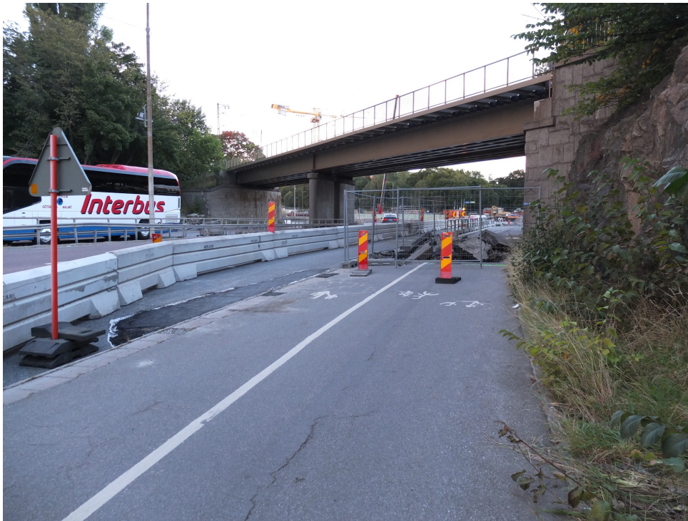
FIGURE 5 – Modification du parcours des cyclistes et piétons lors de la réfection de la voie
