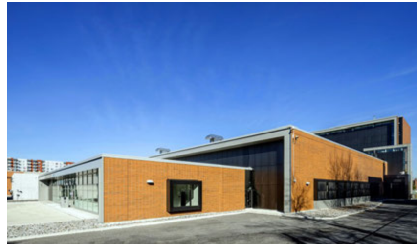
Le poste Bélanger après sa reconstruction
