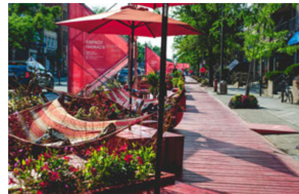
Mise en valeur du chantier rue Saint-Denis, Montréal © Intégral Jean Beaudoin
