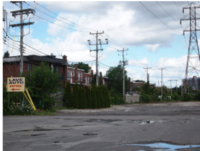
Ligne de distribution d'électricité près de l'emprise d'Hydro-Québec
