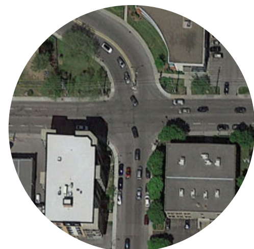
Intersection boulevard Provencher et rue Jean-Talon Est Longueur : 17 m
