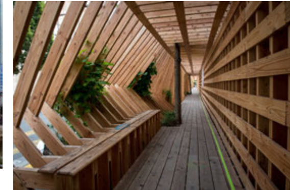
Installation temporaire pour circulation piétonne dans un chantier, Nantes, France © Atelier Vecteur
