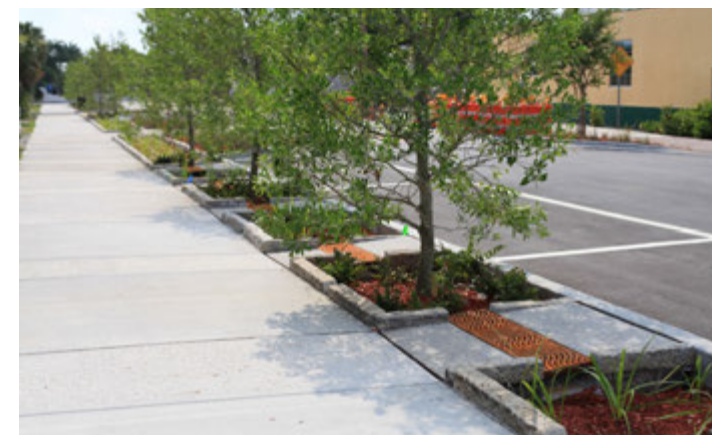
Plantation de rue avec gestion des eaux pluviales, Tarpon Springs © David Conner Associates
