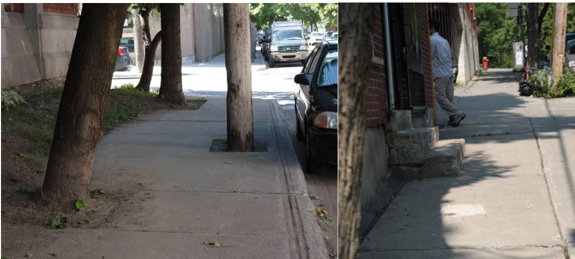
Figure 2 – Exemples d'obstacles sur la voie piétonne
