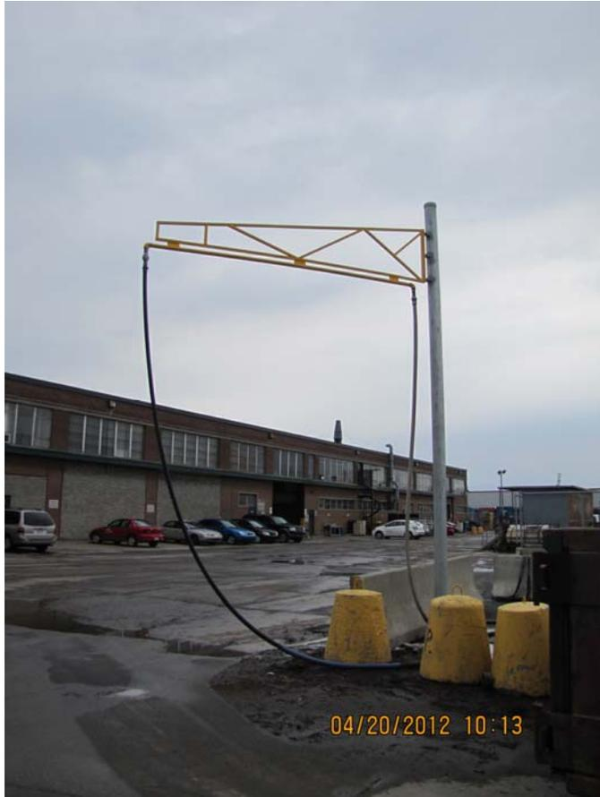
Une potence a été installée pour faciliter la manipulation du boyau d'arrosage. La potence a été installée de façon à permettre une utilisation plus versatile du poste de nettoyage et accommoder un plus grand nombre de véhicules.
