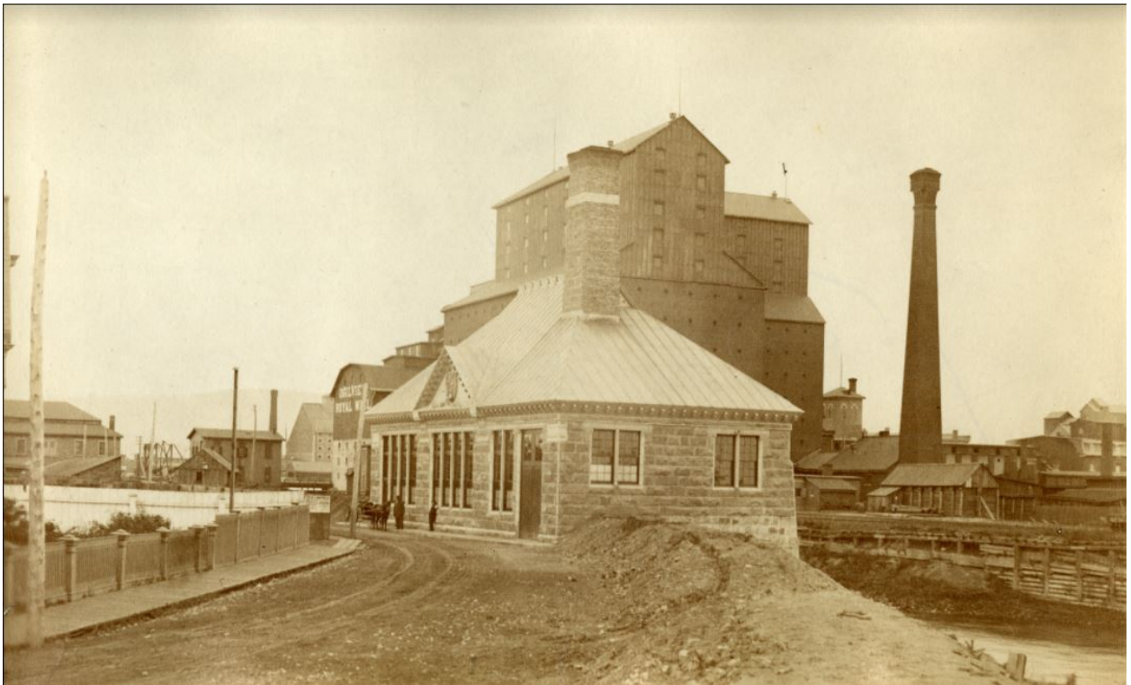
Archives de la Ville de Montréal. Station de pompage Riverside, circa 1888.
