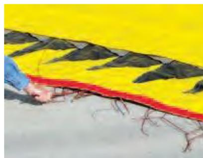
Il faut aussi prendre en considération le relief du terrain. Il se peut que la barrière soit déposée sur une surface avec un trottoir, créant ainsi un espace vide entre le trottoir et la rue qui laissera la place à d'importantes infiltrations d'eau. Dans un tel cas, nous recommandons d'installer un sac de sable pour bien calfeutrer cette ouverture.
