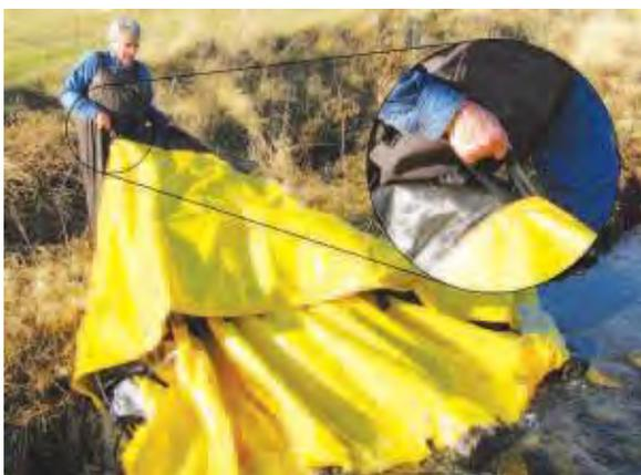
5 – Pour retirer la barrière d'eau, il faut absolument tirer vers l'arrière. Des ganses sont spécialement prévues pour cette manœuvre.
