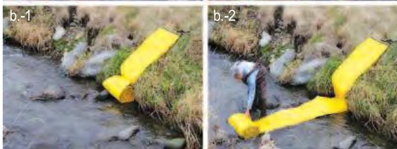
La rapidité du courant dans un cours d'eau ne nuit généralement pas à l'installation de la barrière. Si le courant d'eau est très faible, la barrière déroulée sur le ruisseau flottera; par contre, si le courant d'eau est fort, la barrière d'eau se déposera au fond du cours d'eau. Il y a peu de risque que la barrière parte avec le courant ou se déploie automatiquement.
