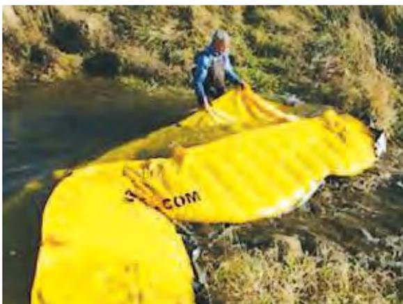
3 – Avancer avec la barrière qui dérape en soutenant la bavette avant en dehors de l'eau. Cette manœuvre périlleuse est recommandée pour empêcher la barrière de s'enrouler sur elle-même et ainsi faciliter son retrait.
