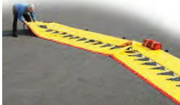
2 - Placer un lestage à l'arrière de la barrière et donner l'angle nécessaire pour contenir l'eau.
