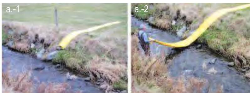
b. Dérouler la barrière directement dans l'eau. Cependant, cette méthode est applicable seulement à partir d'un côté du cours d'eau à cause de la direction du courant d'eau et de l'orientation de la barrière enroulée.
