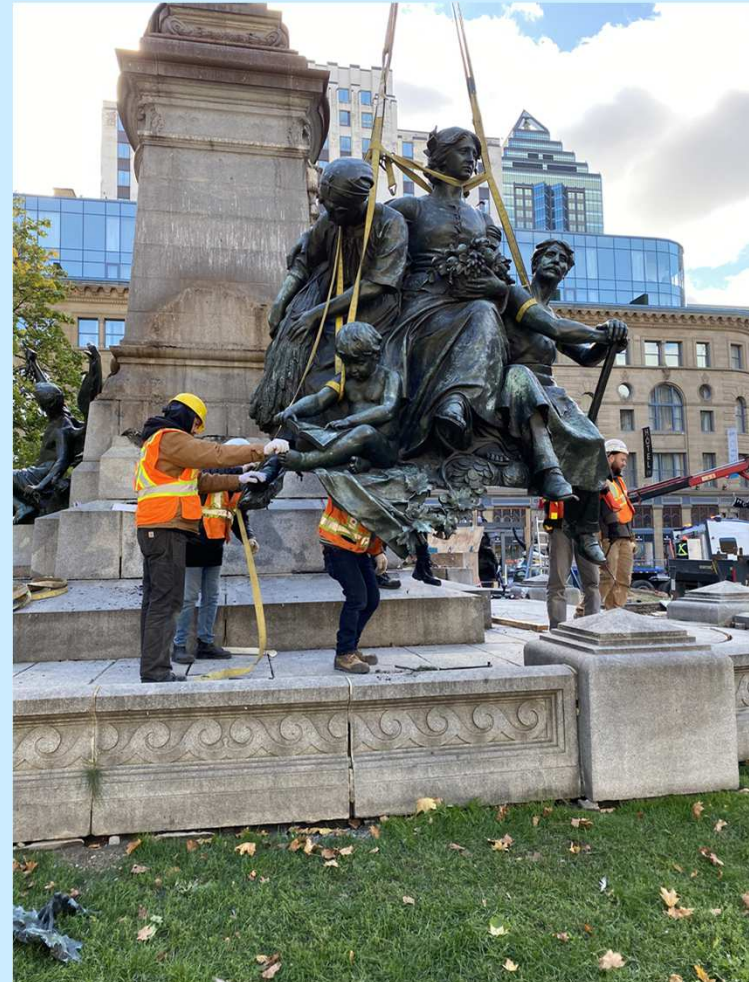
Restauration du Monument à Édouard VII @ Ville de Montréal
