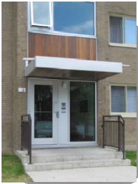
Réfection des marquises d'entrée des bâtiments de 3 étages.
