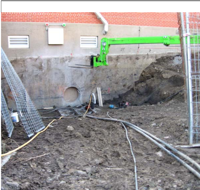
Travaux de mise à niveau - Usine Atwater
