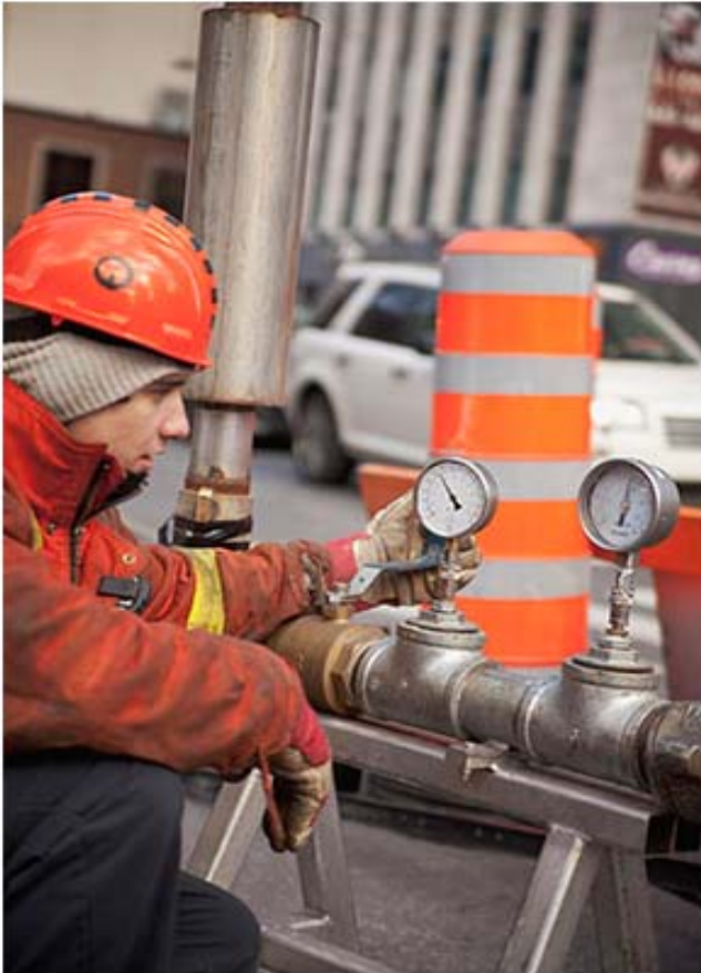
Réhabilitation de conduites
