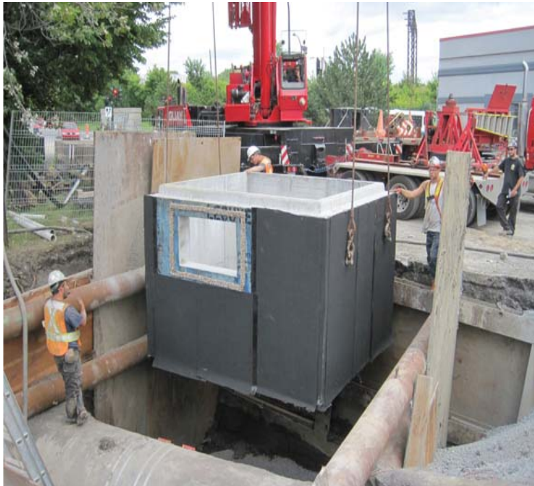
Travaux sur conduite principale - chambre de vanne.
