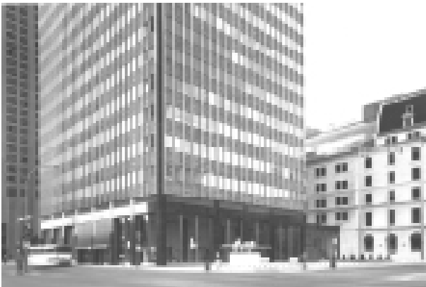
La base et la plaza de la tour de la CIBC vers 1990. Photographie Michel Brunel, Archives Docomomo Québec
