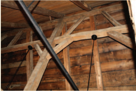
Charpente du toit de la maison assemblée à la française Photo : Ville de Montréal, 2019
