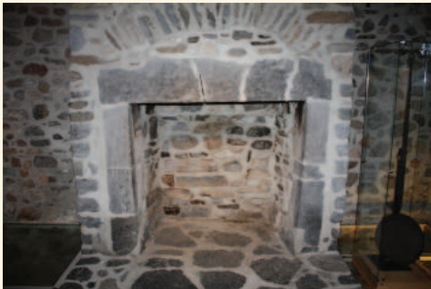
Le foyer est, le plus ancien de la maison Photo : Ville de Montréal, 2019
