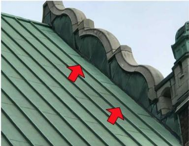
NO.5.MAUVAISE CONDITION DU SOLINAGE DU MUR DE FRONTON SUD
