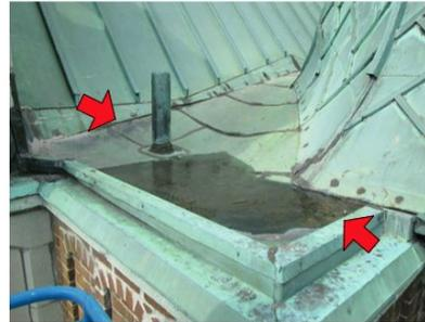
NO.2.LE CAPUCHON MANQUANT ET MAUVAIS GÉRANCE DES PENTES
