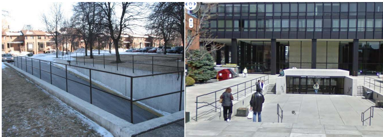
Figure 1. À gauche, les garde-corps actuels menant à un des stationnements souterrains de l'immeuble de la rue Corot. Source : Arrondissement de Verdun, 2011. À droite, la descente vers la galerie commerciale du Westmount Square, sur l'avenue Greene. Source : Google StreetView, consulté le 25 mai 2011.
