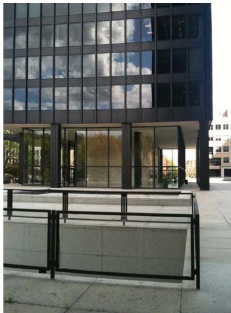
Figure 2. Westmount Square, Montréal. Certains garde-corps ont été modifiés, les montants servent de cadre à des insertions d'un matériau transparent. Source : P. Gauthier, CPM, mai 2011.
