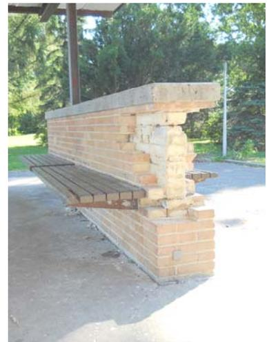
Figure 2. Vue présentant l'état de délabrement du mur le plus bas. Source : Arrondissement Ahuntesic-Cartierville.
