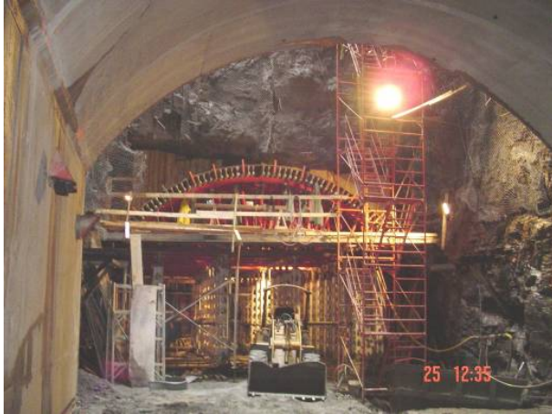
Bétonnage poste de ventilation mécanique
