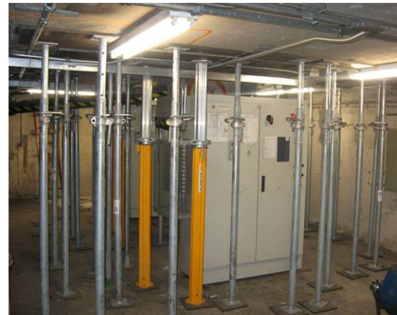
Station - plancher édicule
