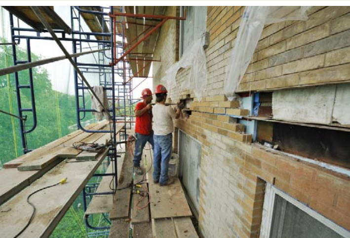
Travaux majeurs aux habitations Saint-Firmin
