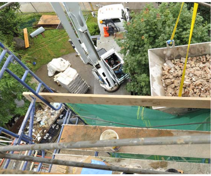
Travaux majeurs aux habitations Saint-Firmin
