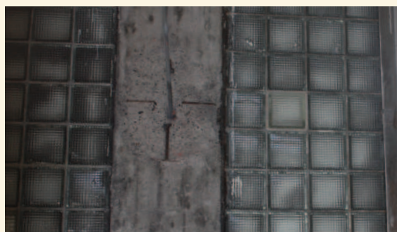
Blocs de verre mis au jour par des travaux de dégarnissage
