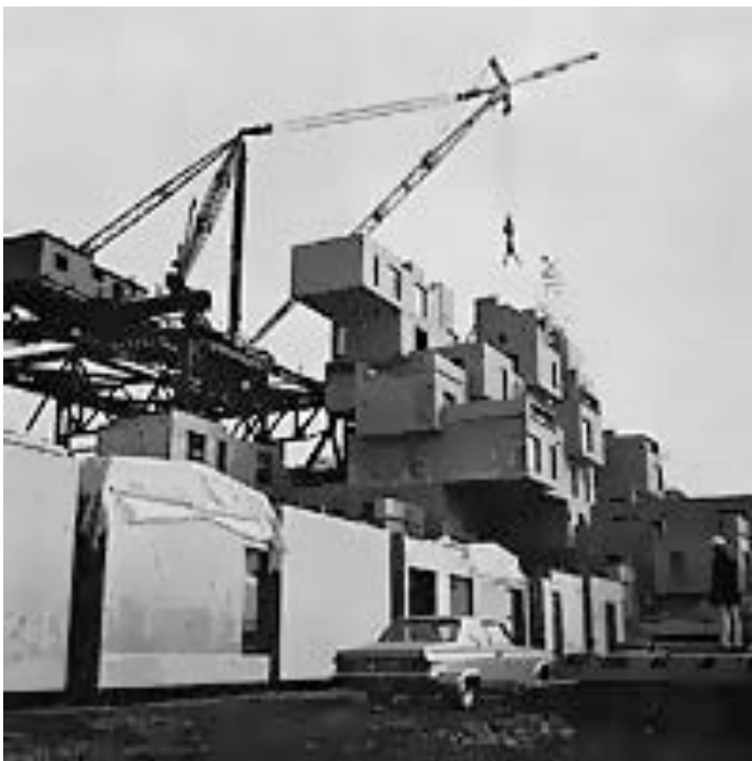
Fig. A.6 Photographie du chantier: vue de la façade nord avec modules en attente d'être assemblés [c. 1966].
