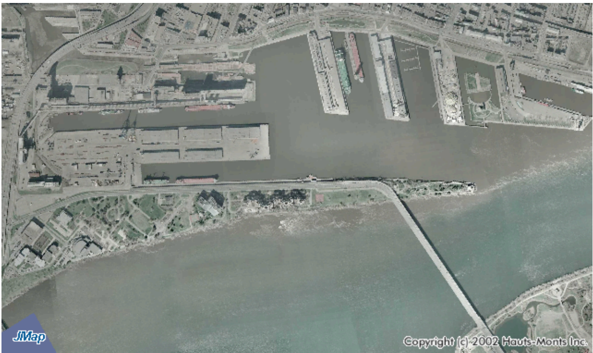
Fig. A.8 Vue aérienne de la Cité du Havre [c. 2002].
