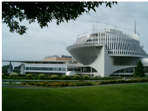
Fig. 4 Vue sur l'ancien pavillon de la France et de l'extension actuelle (2006)
