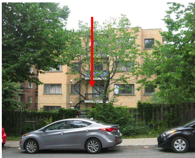
Bâtiment à l'arrière du terrain
