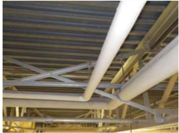
**RC-TX-1 & RC-TX-2** : Rez-de-chaussée – plafond – Calorifuge de tuyauterie – sections rectilignes
