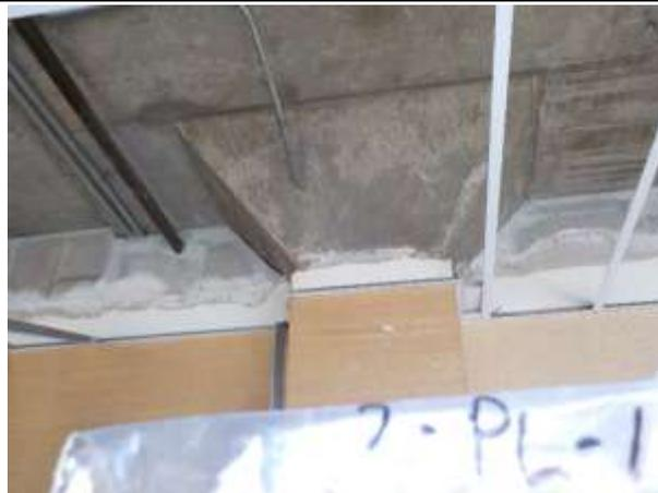
**2-PL-1** : 2<sup>e</sup> étage – colonne – plâtre sur ciment
