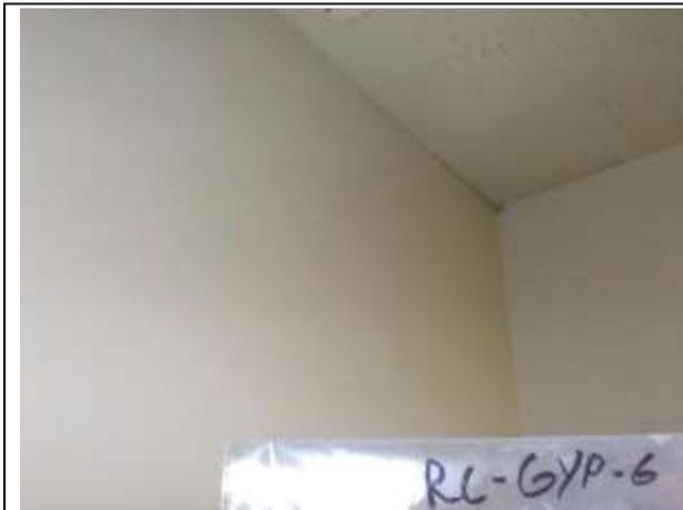
**RC-GYP-6** : Rez-de-chaussée – mur de division – gypse et composé à joint
