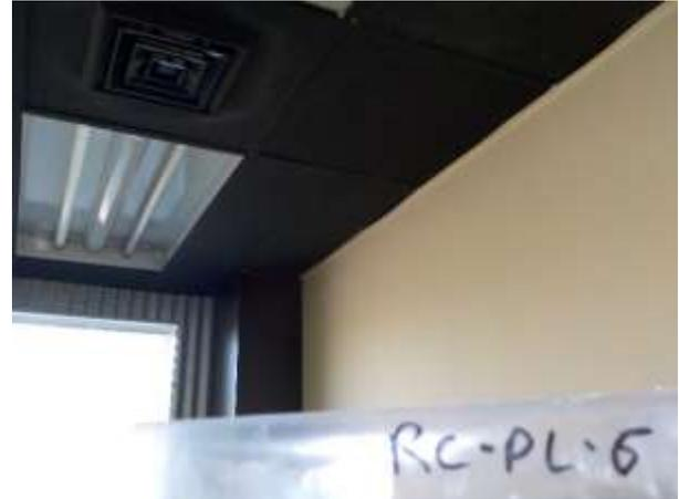
**RC-PL-6** : Rez-de-chaussée – mur de division – plâtre blanc et ciment brun
