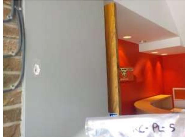
**RC-PL-5** : Rez-de-chaussée – mur de division – plâtre blanc et ciment brun
