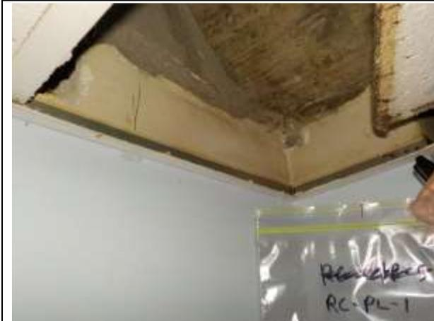
**RC-PL-1** : Rez-de-chaussée – mur de division – plâtre blanc et ciment brun
