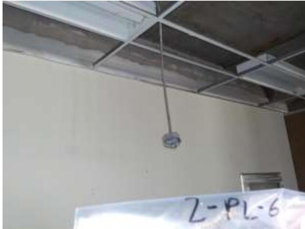
**2-PL-6** : 2<sup>e</sup> étage – colonne – plâtre sur ciment
