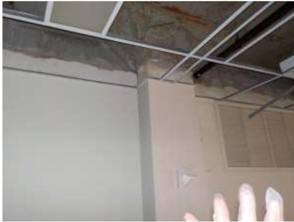
**2-PL-4** : 2<sup>e</sup> étage – colonne – plâtre sur ciment
