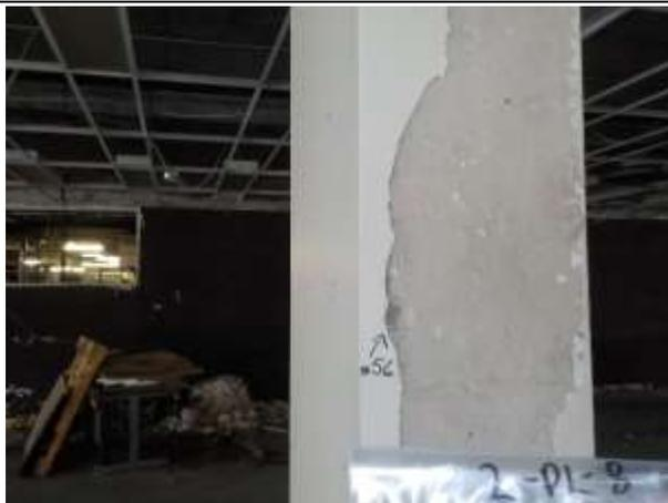
**2-PL-8** : 2<sup>e</sup> étage – colonne – plâtre sur ciment
