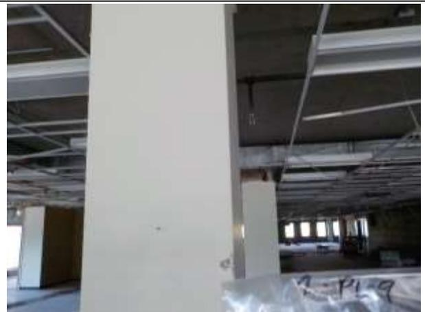
**2-PL-9** : 2<sup>e</sup> étage – colonne – plâtre sur ciment
