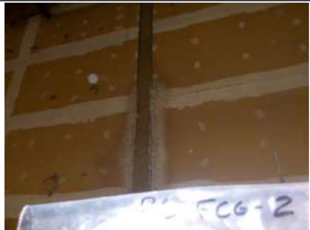
**RC-FCG-2** : Rez-de-chaussée – colonne verticale – Flocage
