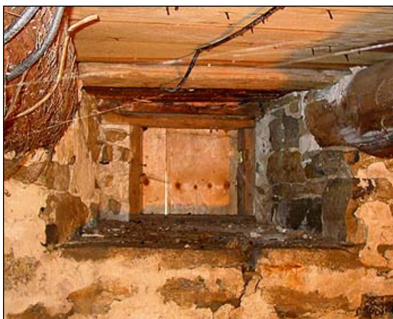
Figure 2.26. Soupirail en avant, sous-sol, maison Richer dit Louveteau, 2007
