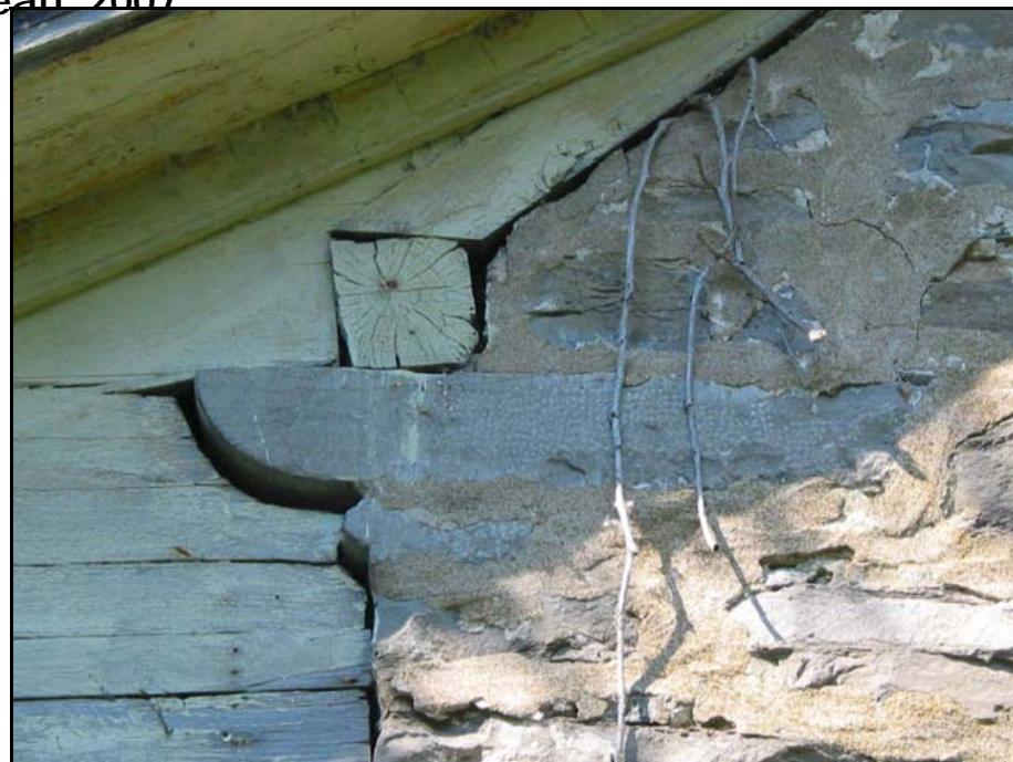
Figure 2.14. Corbeau est, façade avant, maison Richer dit Louveteau, 2007
