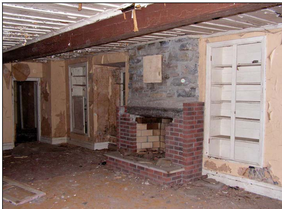
Figure 2.30. Côté est, rez-de-chaussée, maison Richer dit Louveteau, 2007
