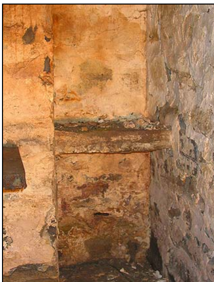
Figure 2.27. Tablette en pierre située entre la masse de la cheminée ouest et le mur de refend, maison Richer dit Louveteau, 2007
