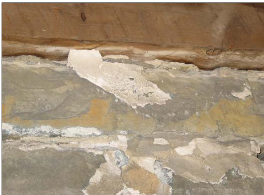
Figure 2.17. Traces de crépi sur des pierres cachées par le larmier. maison Richer dit Louveteau, 2007
