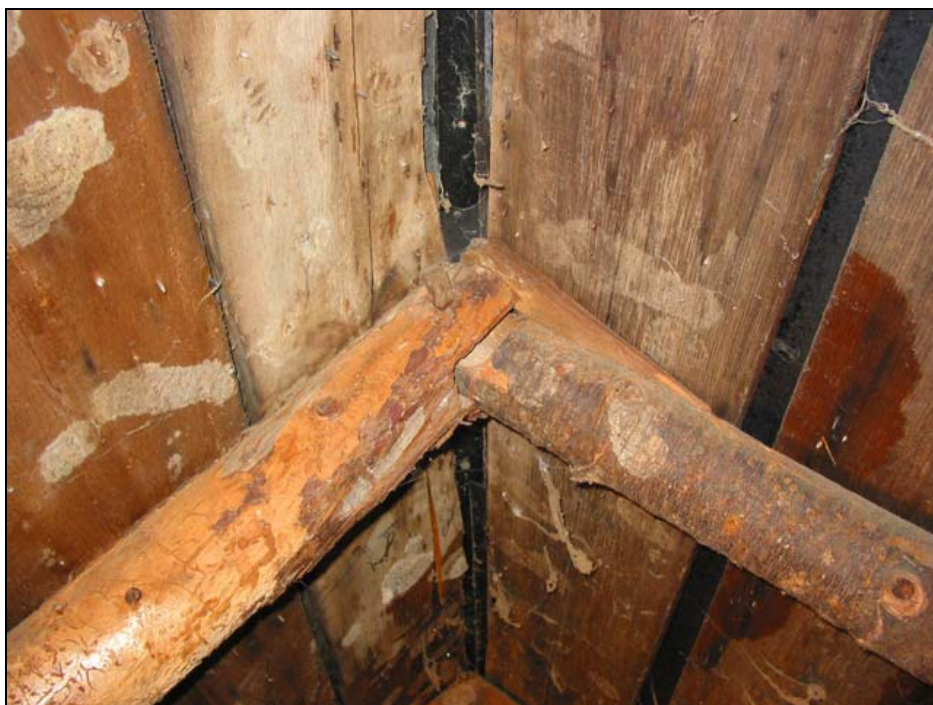
Figure 2.41. Assemblage de ferme, grenier, maison Richer dit Louveteau, 2007
