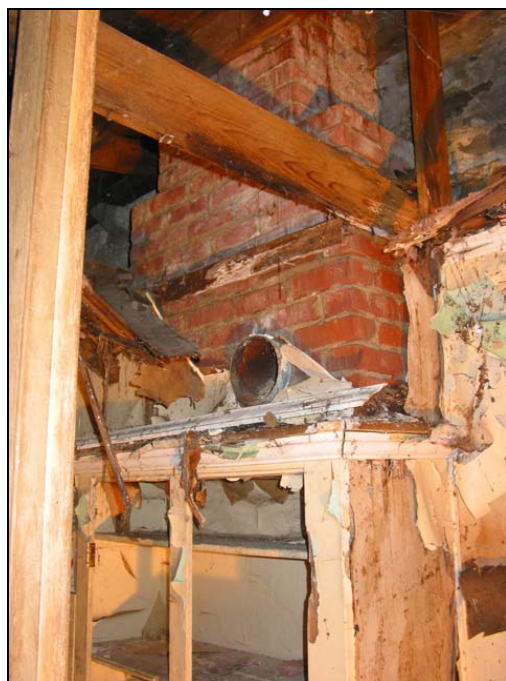
Figure 2.38. Cheminée en brique, adjonction, maison Richer dit Louveteau, 2007
