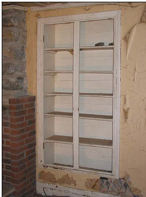
Figure 2.37. Armoire encastrée, côté est, rez-de-chaussée, maison Richer dit Louveteau, 2007
