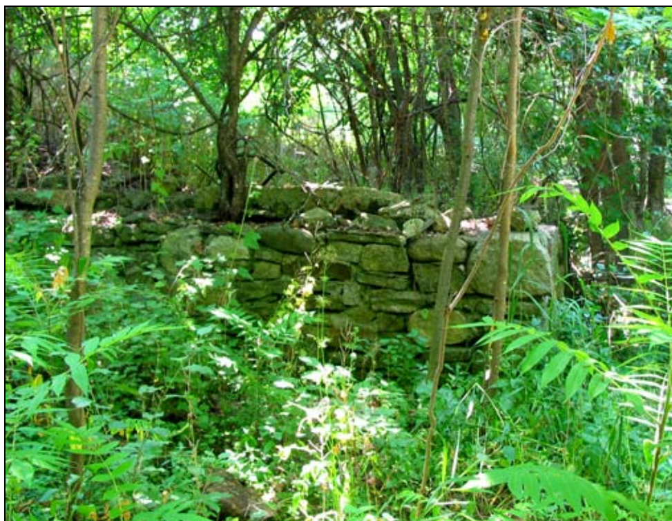
Figure 2.43. Fondations de la dépendance à l'ouest de la maison Richer dit Louveteau, 2007
