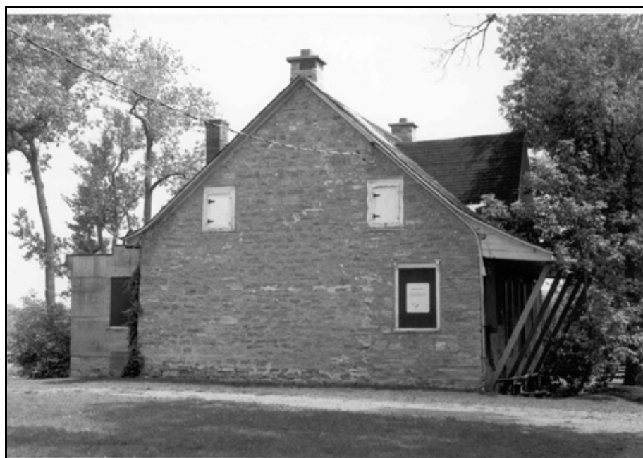
Figure 2.8. La maison Richer dit Louveteau après la démolition de la galerie, vers 1980.
