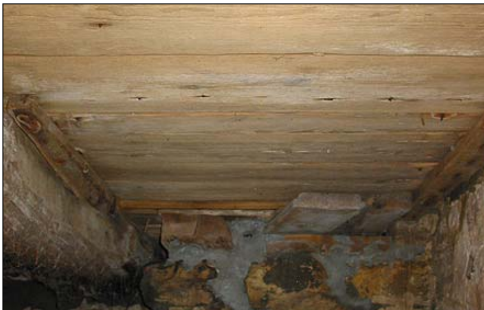
Figure 2.24. Trappe est, sous-sol, maison Richer dit Louveteau, 2007
