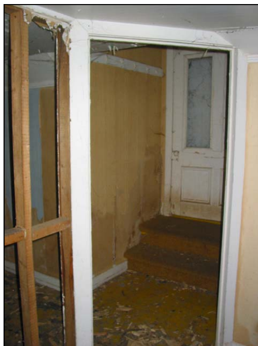
Figure 2.39. Cloisonnement à l'étage du comble et porte de la grande lucarne, maison Richer dit Louveteau, 2007
