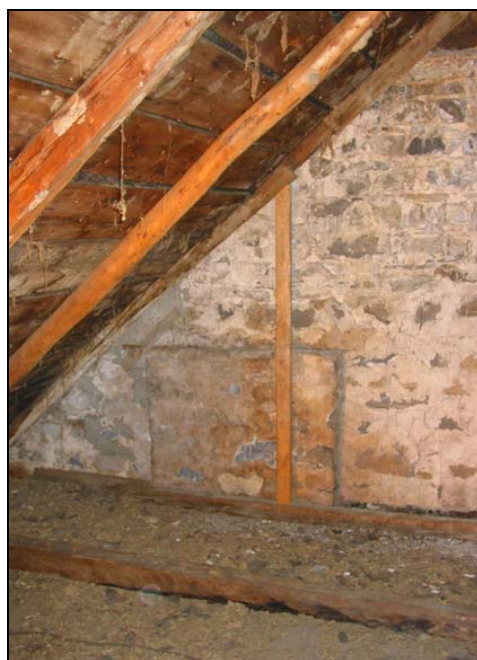
Figure 2.42. Partie supérieure de la cheminée ouest, grenier, maison Richer dit Louveteau, 2007
