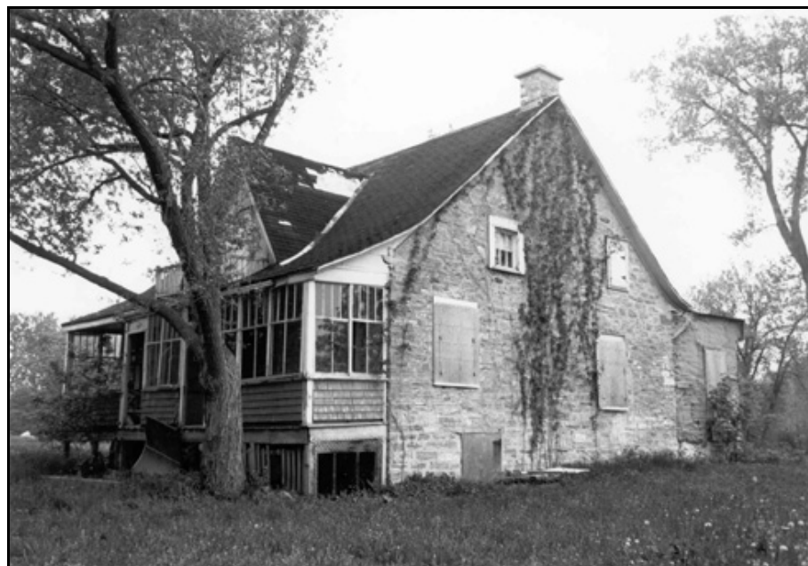
Figure 2.4. La maison Richer dit Louveteau après la démolition de la remise, vers 1980.
