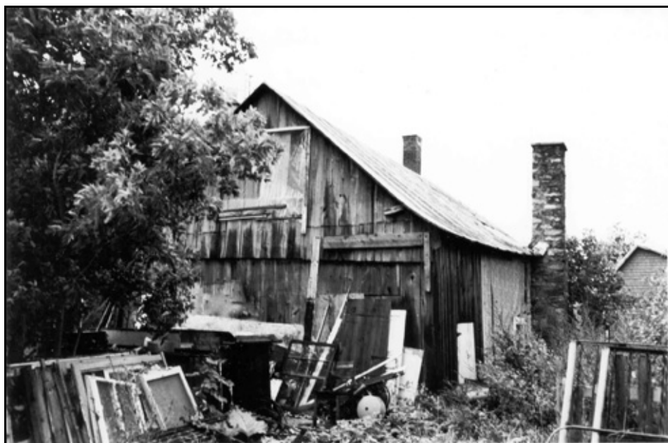
Figure 2.5. Le pignon est et l'arrière de la remise attachée à la maison Richer dit Louveteau, vers 1975
