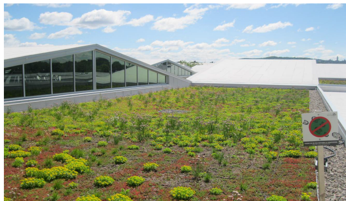
Illustration 2 : Toit végétalisé (rue Stinson)
