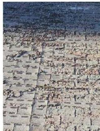
Complexe aquatique : mortier déficient, risque de chute de pierres et de briques, fissures au balcon.
