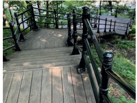
Escalier comparable en acier et platelage de bois
