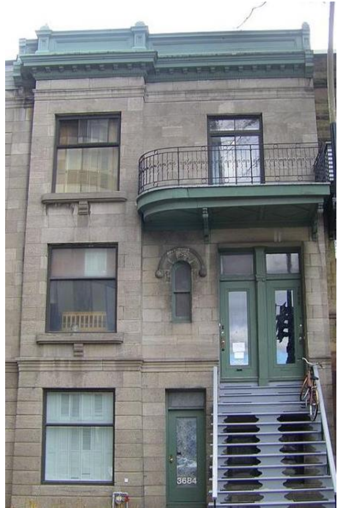
Un des bâtiments faisant partie de l'inventaire du site Patrimonial du Mont-Royal (coopérative Tour des Alentours)
