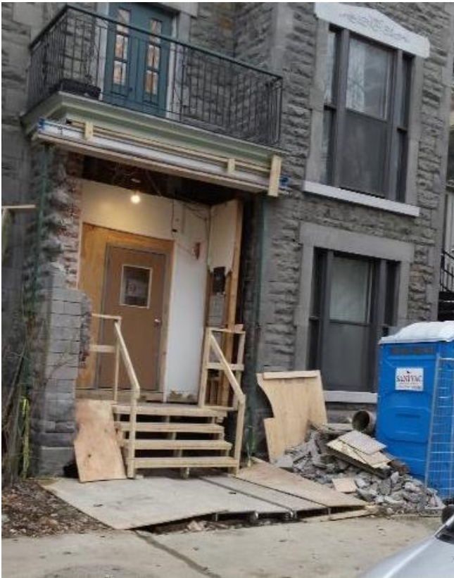
Pendant les travaux
