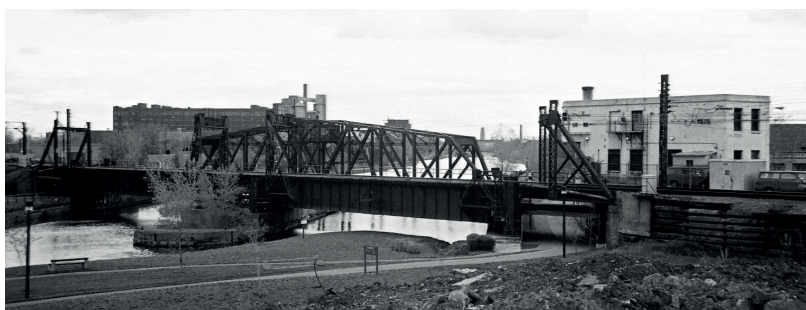
Le pont ferroviaire du CN ainsi que le poste de contrôle, 1984 Gabriel Bodson
