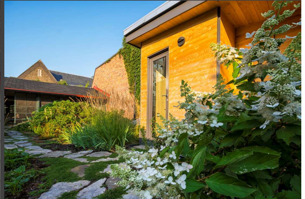
Toiture végétalisée et terrasse récréative, Montréal (2006 et 2014) rose architecture entremise construction
