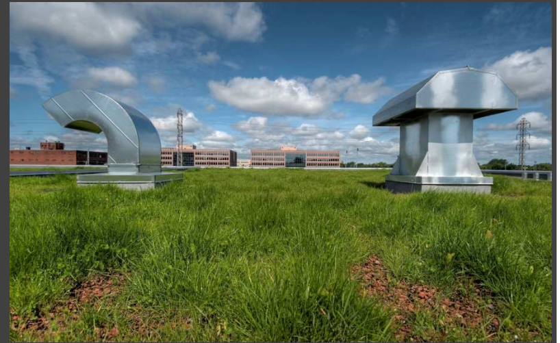
Centre de carrosserie Legendre, STM (2008) provencher_roy toits vertige
