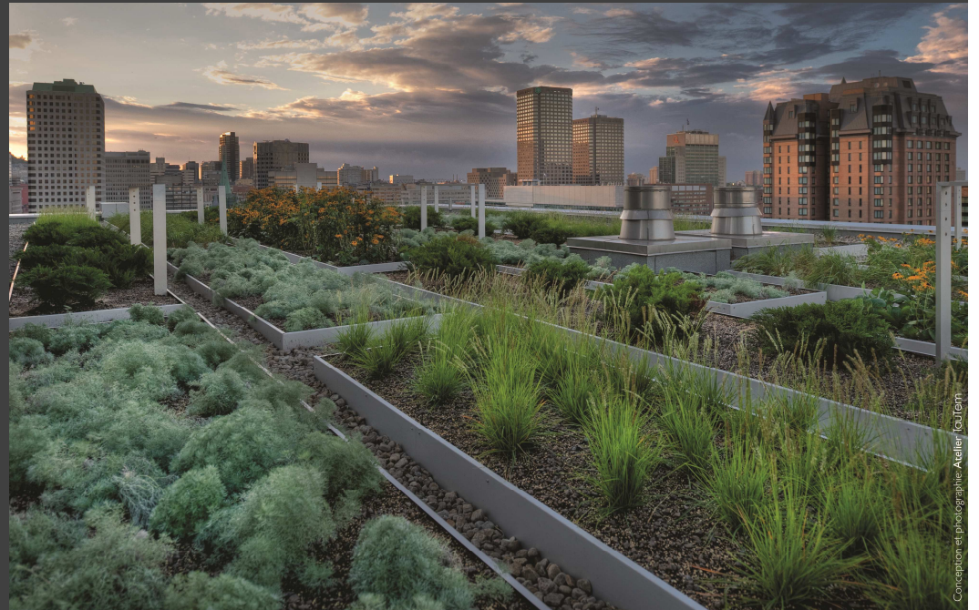
Toit vert, Quebecor Média (2010) atelier tautem toits vertige
