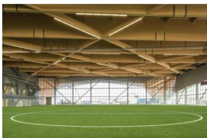
Inauguré en 2015 dans le Complexe Environnemental Saint-Michel, le stade est certifié LEED Or pour sa consommation énergétique. Il est muni de 10 puits géothermiques pour le chauffage et l'aération, la chaleur des eaux usées des douches est utilisée pour préchauffer l'eau avant son arrivée dans le chauffe-eau, l'éclairage du terrain s'adapte automatiquement à la quantité de lumière naturelle grâce à des détecteurs, et la structure porteuse est faite en bois provenant du
