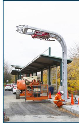
Dans le cadre du projet **Cité Mobilité Montréal** de la STM, un premier pantographe, bras articulé qui assure en moins de 5 minutes une recharge partielle par conduction des batteries situées sur le toit du véhicule, vient d'être installé au terminus Angrignon.
