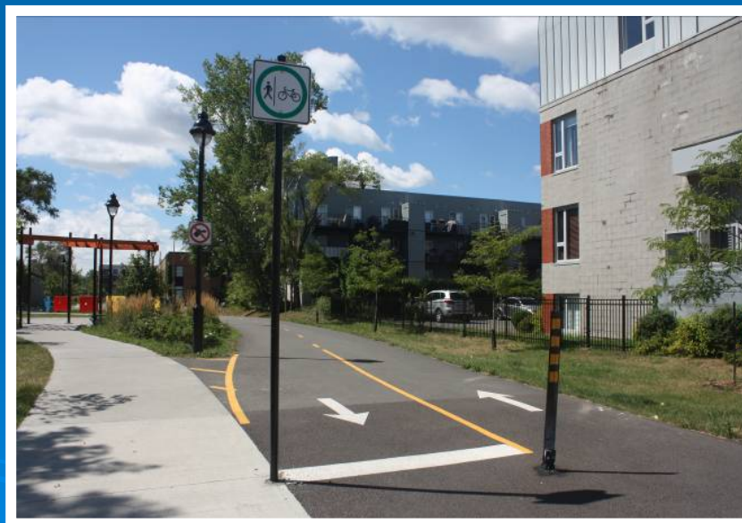
Antenne ferroviaire Longue-Pointe
