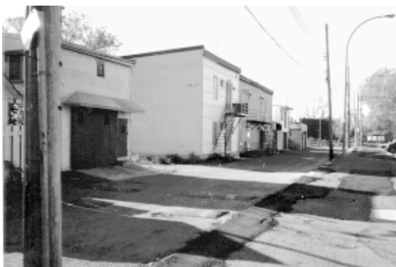
Les logements donnant sur le site du marché.
