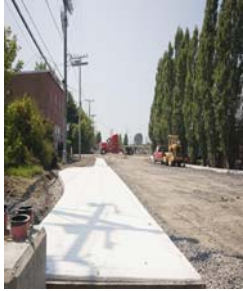
Surveillance des travaux
