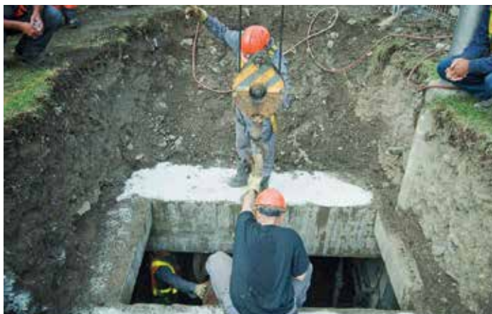
Remplacement d'une chambre de vanne
