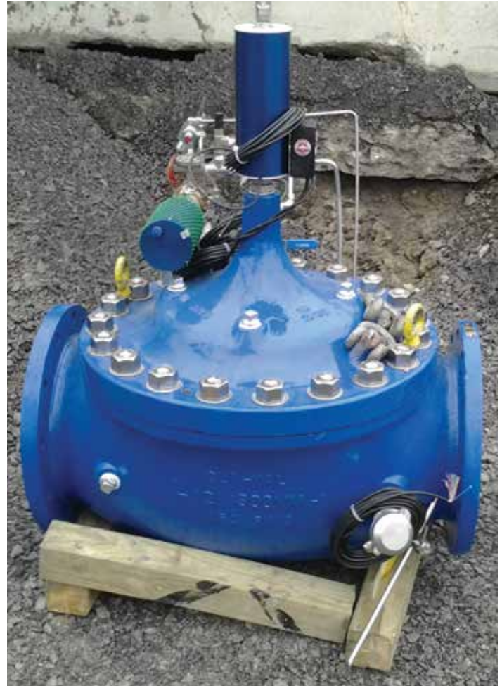
Vanne de régulation de pression en voie d'être installée à Notre-Dame-de-Grâce
