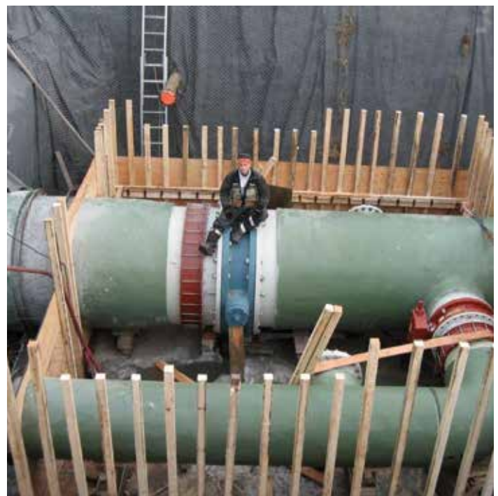
Réhabilitation d'une conduite primaire sur Pie-IX
