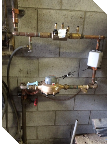
Exemples d'installations de compteurs d'eau
