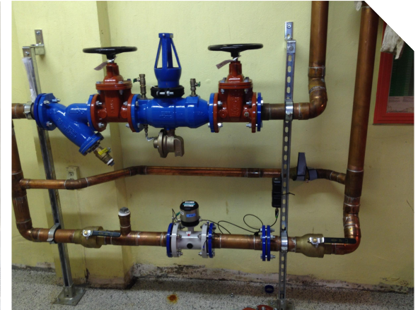
Exemples d'installations de compteurs d'eau
