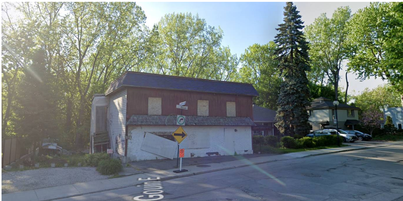
Le bâtiment en 2019 (Source : Cartes Google, site consulté en février 2022)
