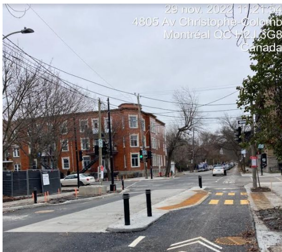
Exemple de quai d'autobus en béton - avenue Christophe-Colomb
