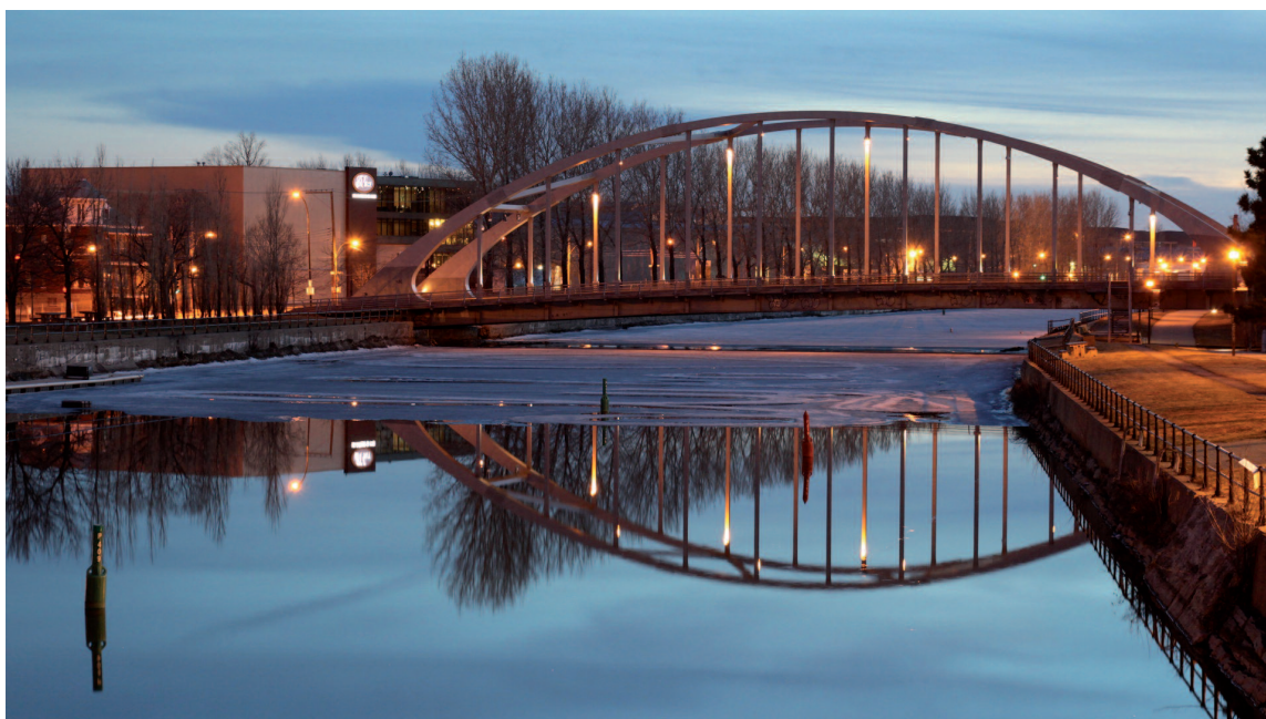
Les deux nouveaux ponts seraient construits sur le modèle du pont Monk.
