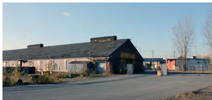
Photo des halles de la Cintube
