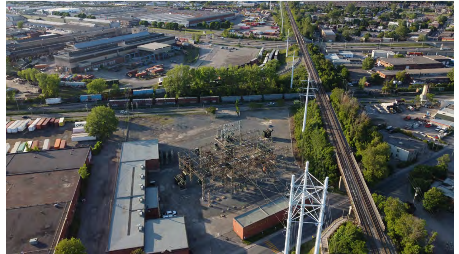
Vue aérienne du poste d'Hydro-Québec (juin 2021)
