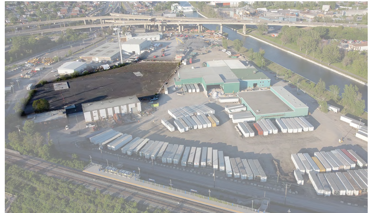
Vue aérienne du bassin de rétention Rockfield se connectant au canal de Lachine (juin 2021)
