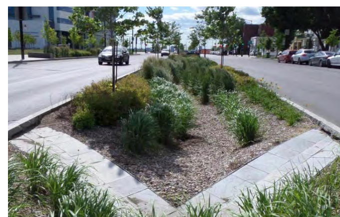
Exemple de bassin drainant en terre-plein central (boulevard Décarie, Montréal)
