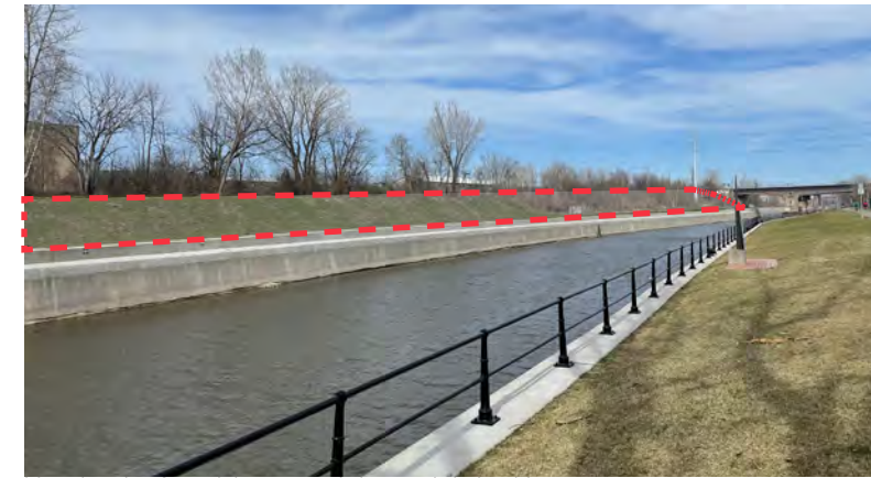
Vue du talus ferroviaire au nord du canal de Lachine
