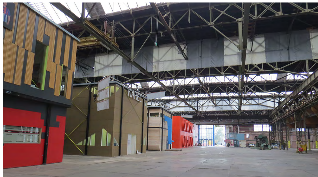
Images de référence de conversion de bâtiments d'intérêt patrimonial (NDSM, Amsterdam)
