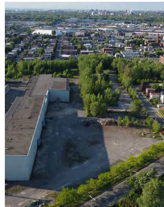
Vue à l'est de la Dominion Bridge
