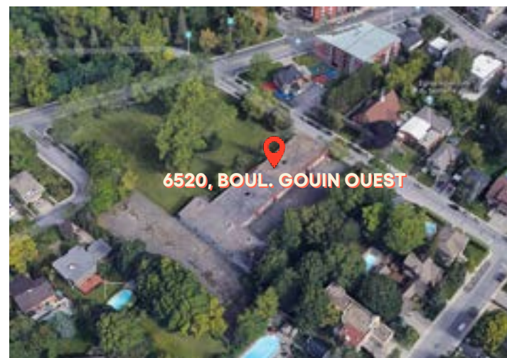
Fig. 285. Immeuble du 6520, boulevard Gouin Ouest (CSDM) (Source photo: Google Maps)
