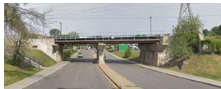
Fig. 88. Rue Grenet (Source: Streetview, Août 2018)
