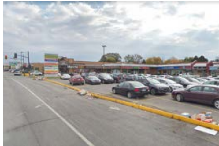
Fig. 65.Centre Cartierville (Source: Google)
