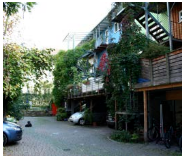
Fig. 297. Stationnements dissimulés sous les terrasses, Fribourg-en-Brigau, Allemagne (Source: Vivre en Ville)
