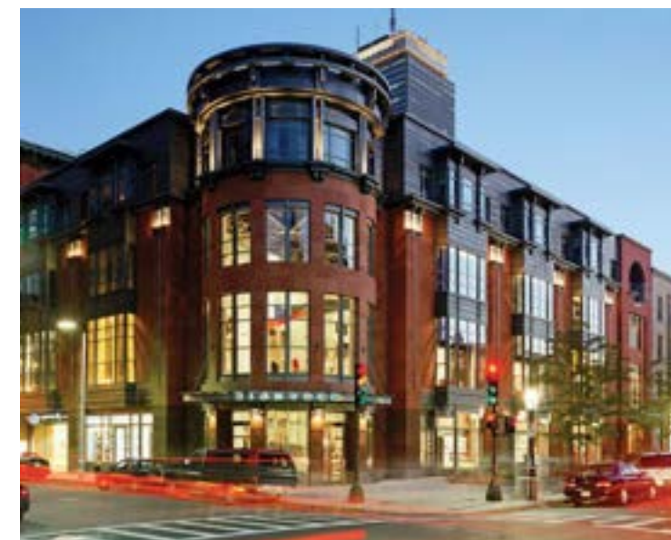
Fig. 269.Marquage de l'entrée principale, Boston, États-Unis (Source: Newbury Street)
