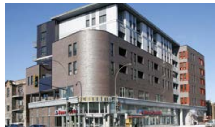
Fig. 293. Terminus intégré à un projet mixte (résidence pour personnes âgées/bureau), Station de métro Jean-Talton, Montréal (Source: Résidence en harmonie)
