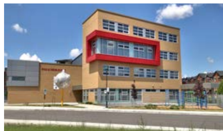
Fig. 251. École du Trésor-du-Boisé, 4 étages, Saint-Laurent, Montréal (Source: CSMB)
