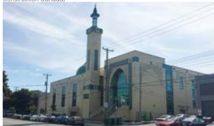
Fig. 222. Centre islamique du Québec (ICQ) implanté sur le chemin Laval à proximité de la rue Grenet (Source: Provencher Roy)
