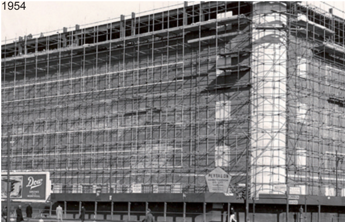
Bâtiment en construction au coin des rue Notre-Dame et Peel Archives de la brasserie Molson
