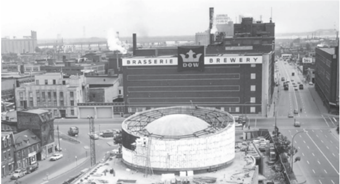
Le Planétarium Dow en construction Ville de Montréal
