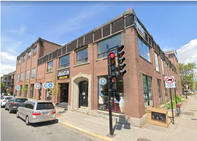
Le 7501-7509, boulevard Saint-Laurent (source : Cartes Google, 2021)
