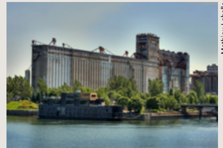
Le silo n° 5 marquant le paysage du front maritime et portuaire de Montréal
