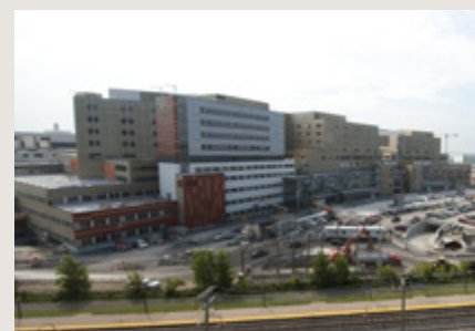
Le CUSM en construction
