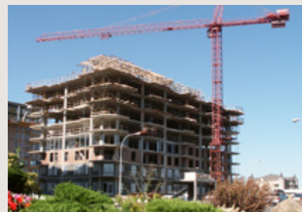
Immeuble résidentiel en construction
