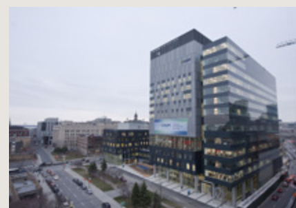
Le CHUM en construction
