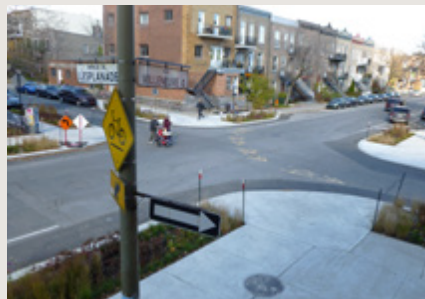
Intersection avec saillies de trottoirs qui favorisent la sécurité du piéton
