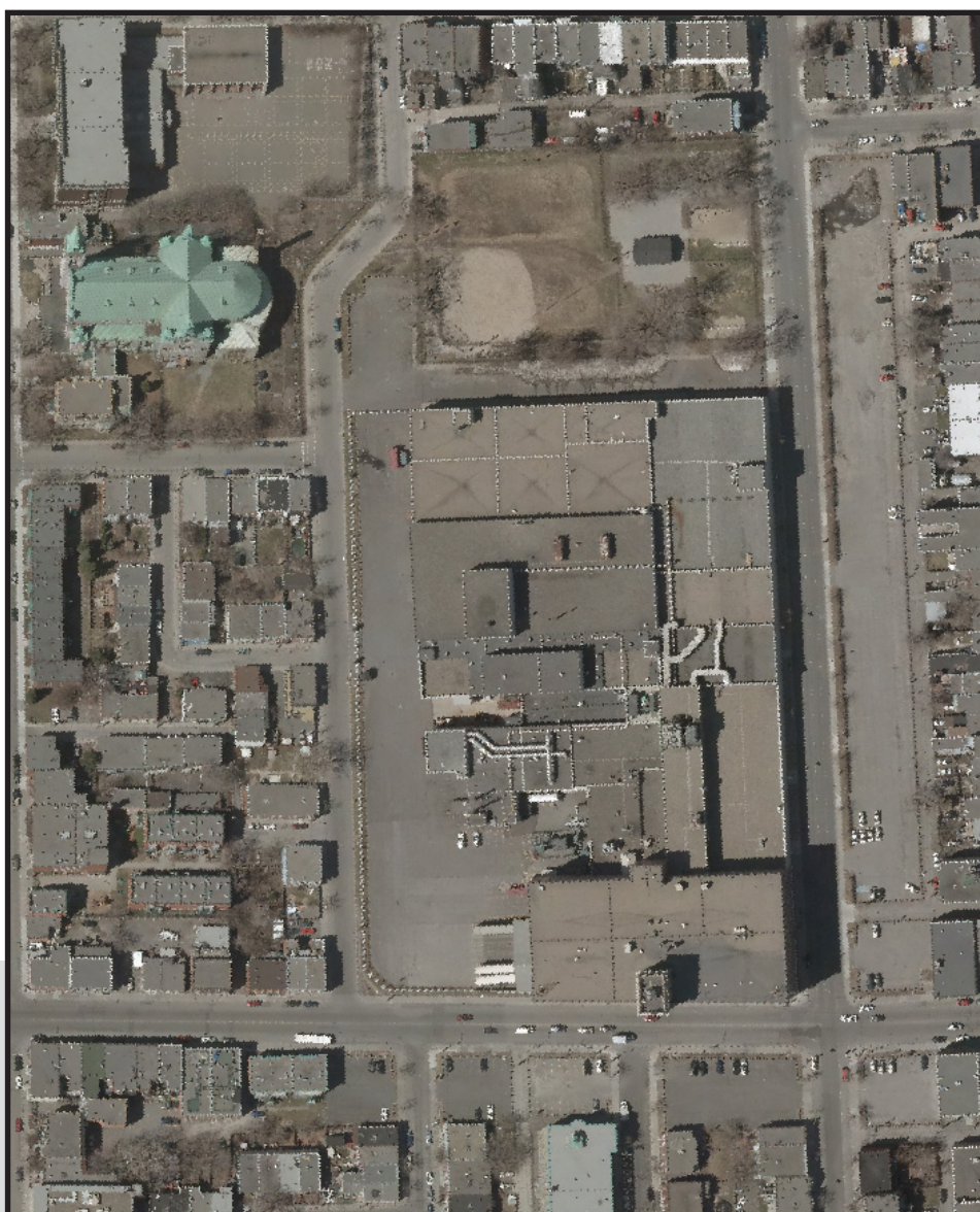
Photo aérienne – Secteur de la JTI-Macdonald
