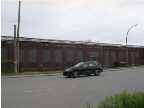
Le bâtiment A et son enseigne peinte le long de Notre-Dame, Lafontaine, 2019
