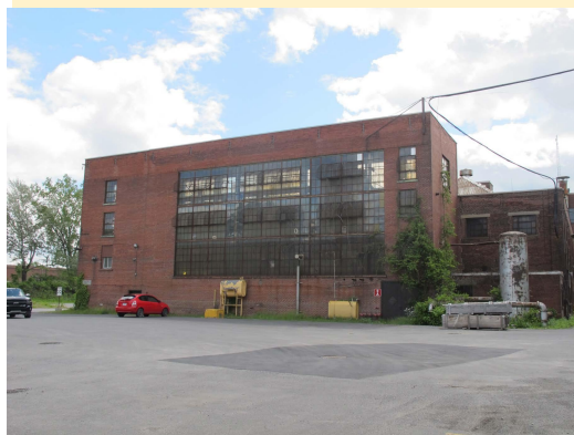
Bâtiment I (chaufferie). Luce Lafontaine, 2019
