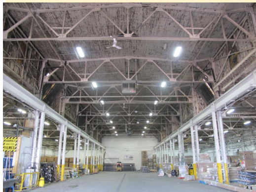
Bâtiment A ( Bolster Shop ). Luce Lafontaine, 2019
