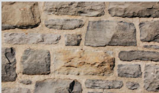
Appareil de maçonnerie « scottish bond » sur le pavillon des Femmes (F).
