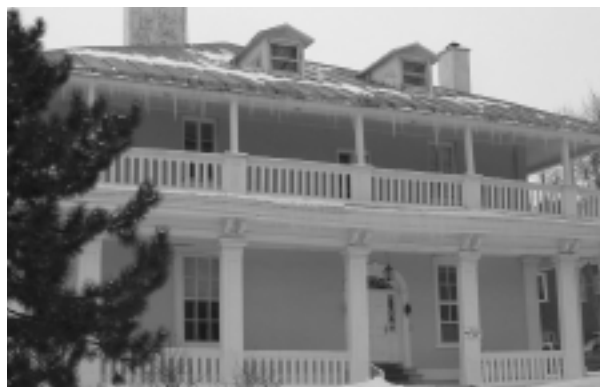
23.E.1 Maison Braemar, 3219, The Boulevard (Crédit photographique: Patri-Arch, 2003)
