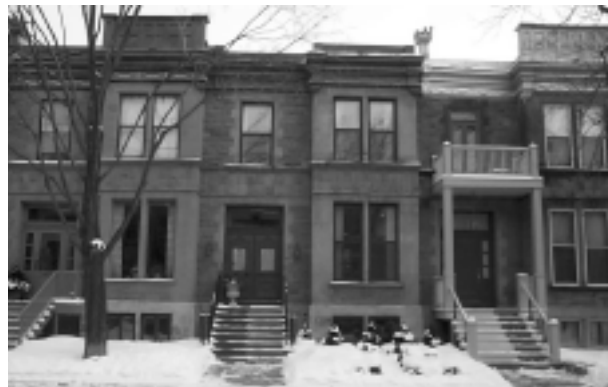
23.E.10 447, avenue Elm (Crédit photographique : Patri-Arch, 2003)
