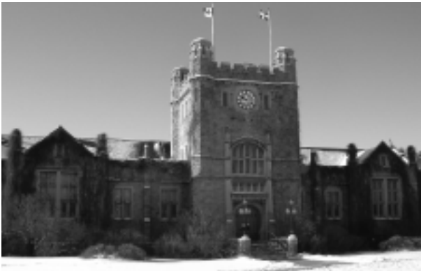
23.E.18 Ancien hôtel de ville de Westmount, 4333, rue Sherbrooke Ouest (Crédit photographique: Patri-Arch, 2003)
